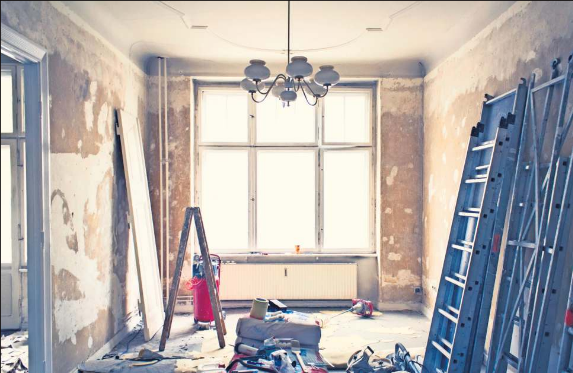
Ein Umbau ist teuer. Daher empfiehlt es sich, nach möglichen staatlichen Zuschüssen zu suchen. Bei energetischen Sanierungen gibt es da viele Möglichkeiten.
